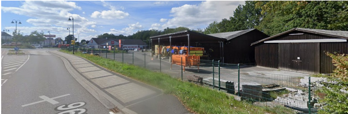
Ansicht Salzlager östlicher Stadteingang (Quelle Google StreetView)
