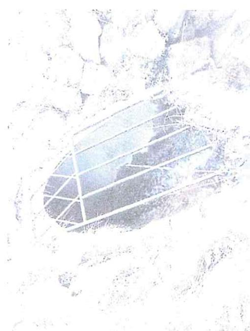
Abb. 4-39: Mit einem Raumrechen zu ersetzen Rechen vor Verrohrung des Beybaches
