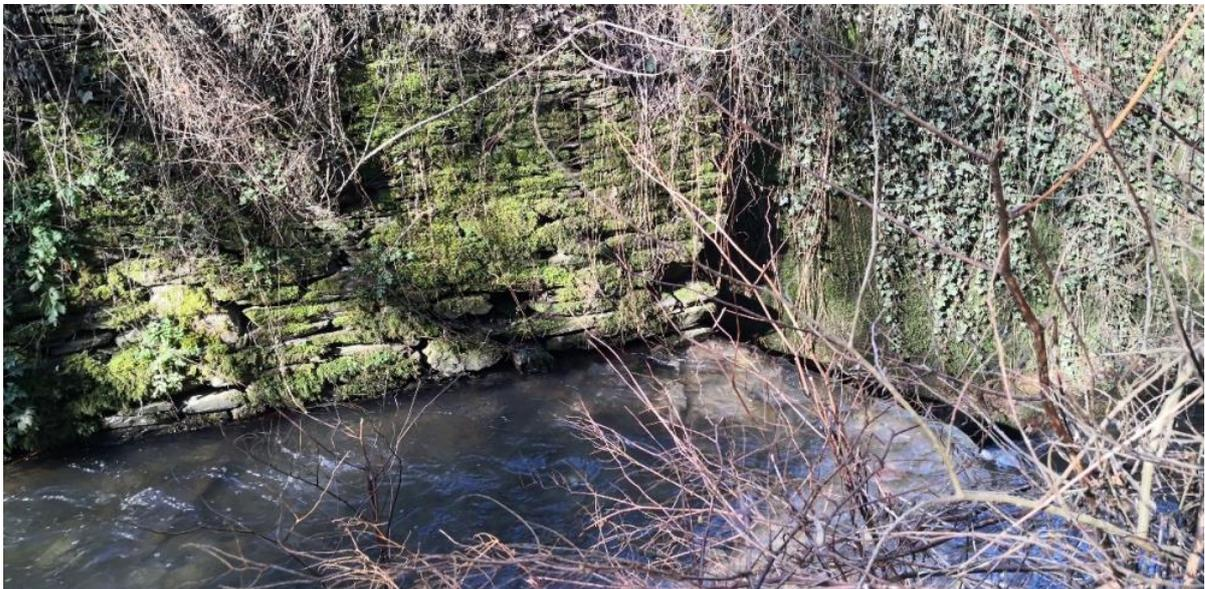
Abb. 4-97: Beispiel einer schon unterspülten Steinstützmauer am Verlauf des Niederbaches
