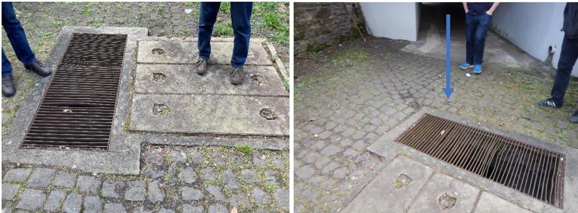
Abb. 4-69: Verschlossener Schacht (links); Fließweg unterhalb der Bahntrasse (rechts)
