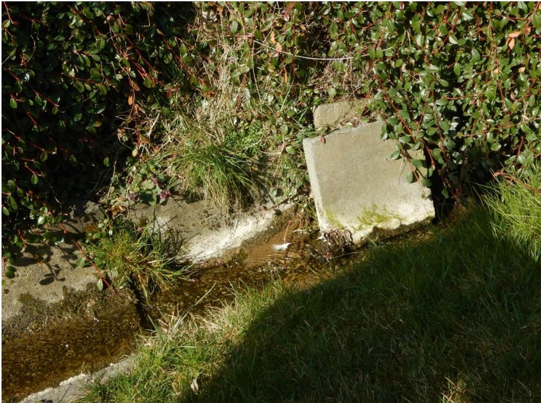
Abb. 4-34: Private Steinplatten, die im Starkregenfall den Durchlass verlegen (H01)
