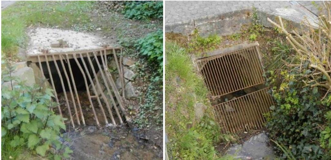
Abb. 4-2: Ungünstiger Einlauf einer Verrohrung
