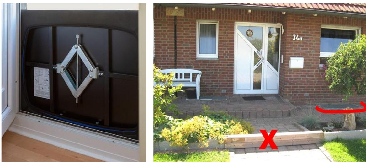
Abb. 3-2: Beispiele Objektschutz: Mobile Türdichtung (links); Aufmauerung um Lichtschacht (rechts)
