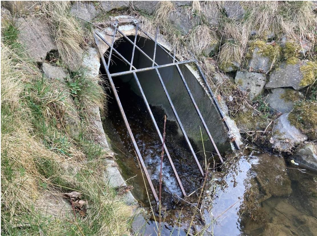
Abb. 4-39: Mit einem Raumrechen zu ersetzenden Rechen vor Verrohrung des Baybaches
