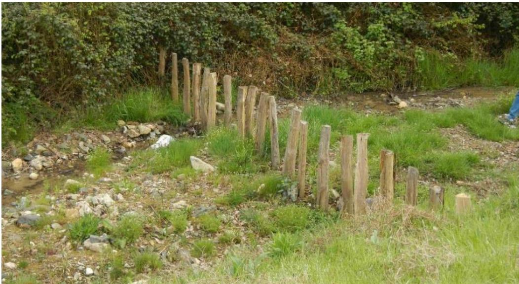
Abb. 4-1: Pfahlreihen zum Treibgutrückhalt im Vorfeld einer Verrohrung
