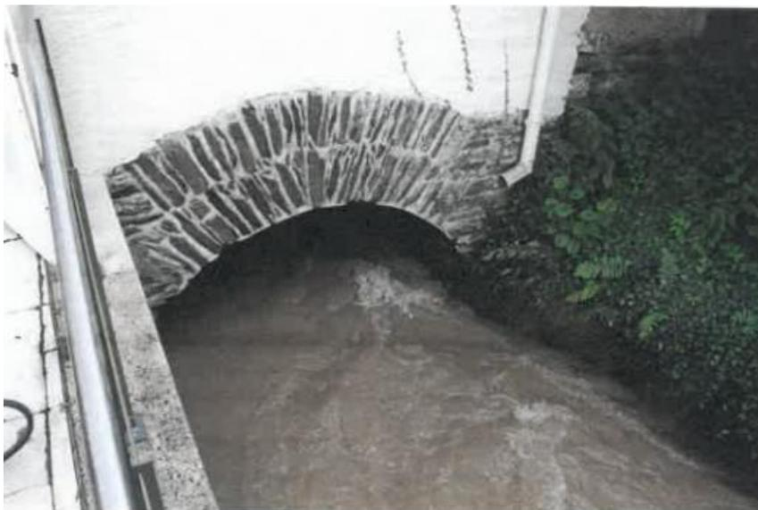
Abb. 4-57: Gewölbe über Gründelbach – Vergleich Normalzustand – Hochwasser (2016)
