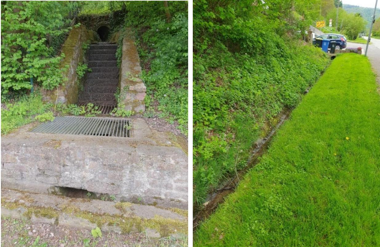
Abb. 4-55: Einlaufbauwerk des Schlittenbachs (links); seitliche Ableitung durch Straßenseitengraben
