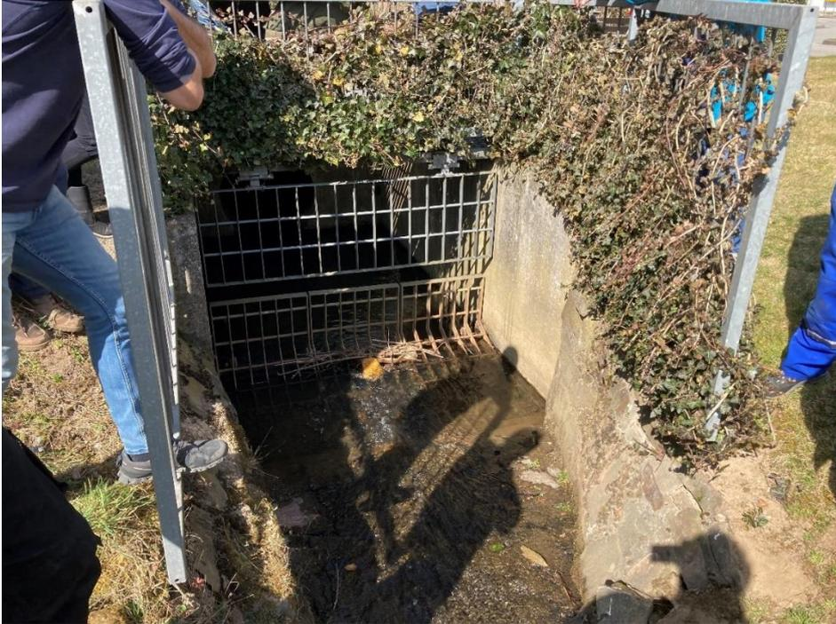
Abb. 4-28: Einlaufbauwerk des Lingerhahner Bachs, das Gitter ist zu klein (H09)
